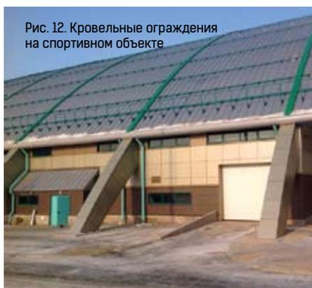
Рис. 12. Кровельные ограждения на спортивном объекте
