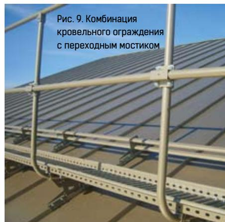
Рис. 9. Комбинация кровельного ограждения с переходным мостиком
