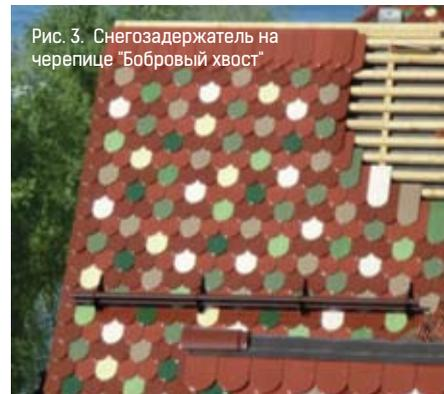
Рис. 3. Снегозадержатель на черепице "Бобровый хвост"
