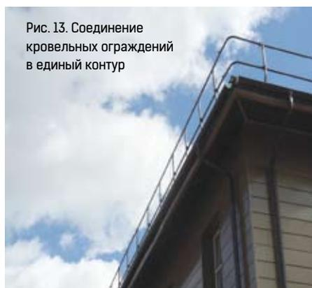
Рис. 13. Соединение кровельных ограждений в единый контур
