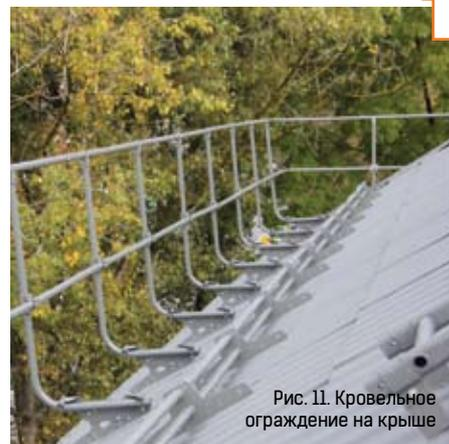
Рис. 11. Кровельное ограждение на крыше
