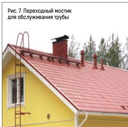
Рис. 7. Переходный мостик для обслуживания трубы
