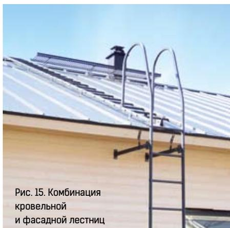
Рис. 15. Комбинация кровельной и фасадной лестниц
