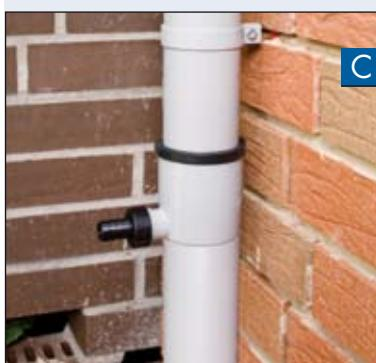
Отборник дождевой воды соединяется с бочкой для дождевой воды с помощью шланга на  $\frac{3}{4}$  дюйма – таким образом Вы получаете бесплатную дождевую воду на радость Вашему саду и Вашему кошельку.
