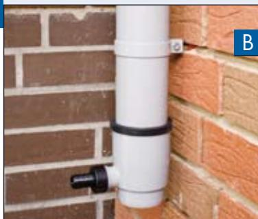
Выставление высоты отборника дождевой воды по верхнему краю бочки для дождевой воды включает переливной клапан: по принципу сообщающихся сосудов вода течет назад в водосточную трубу, когда бочка заполнилась.
