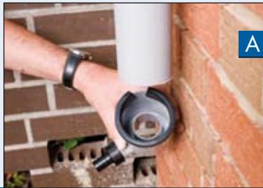
Отборник дождевой воды Marley просто надевается на водосточную трубу.
