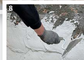
5–8. В кирпичной кладке просверливают отверстия, инъецируя в них гидроизоляцию. Затем поверхность обрабатывают цементным раствором
