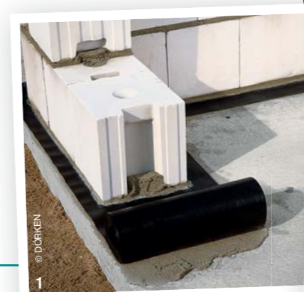
Устройство отсечной гидроизоляции в случае каркасного здания:
