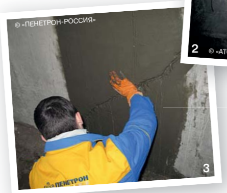
1, 3. Нанесение на стену бетонного фундамента проникающего состава 2. Заполнение шпуров в кирпичной стене гидроизоляционным материалом 4, 9. Рулонная отсечная гидроизоляция поверх ленточного фундамента
